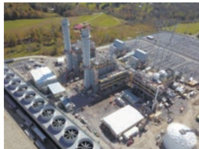
フェアビュー天然ガス火力発電所 （米国ペンシルベニア州）
