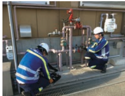
ガス供給設備（緊急遮断弁）の点検作業の様子
