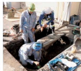
復旧作業（ガス管修繕）の様子
