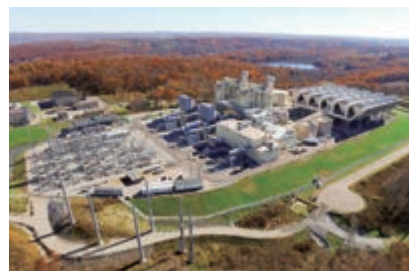
トワンティック発電所（米国コネチカット州）
