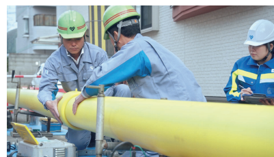
耐震仕様のガス導管（ポリエチレン管）の埋設準備作業
