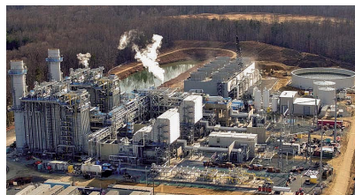
セントチャールズ天然ガス火力発電所
