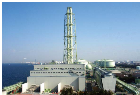
泉北天然ガス発電所（大阪府）
