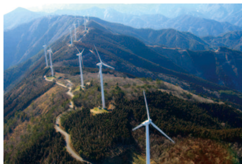
葉山風力発電所(高知県)
