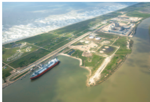
フリーポートLNG基地 (提供:Freeport LNG Development,L.P.)
