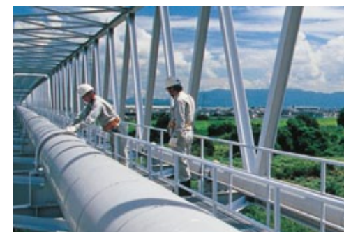
橋梁管の安全点検
