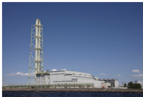
泉北天然ガス発電所(大阪府)
