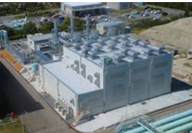
四日市発電所
