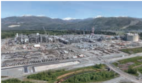
LNGカナダプロジェクト（建設中）
