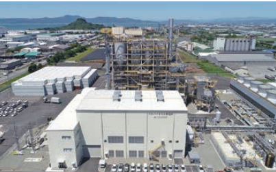
八代バイオマス発電所
