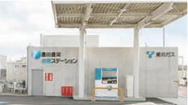
豊田豊栄水素ステーション
