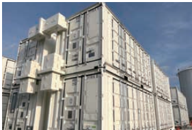
津蓄電所（建設中）
