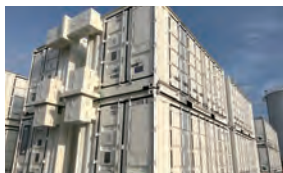
津蓄電所(建設中)
