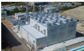
四日市発電所
