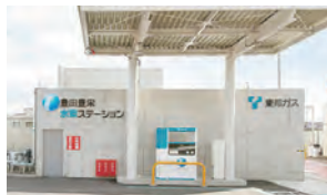
豊田豊栄水素ステーション
