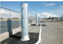
工場の漂流物対策「津波スクリーン」
