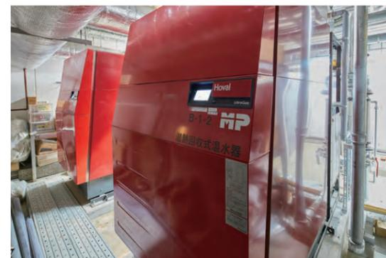
潜熱回収式温水器
