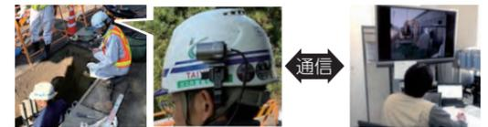
ウェアラブルカメラを用いた現場の遠隔確認
