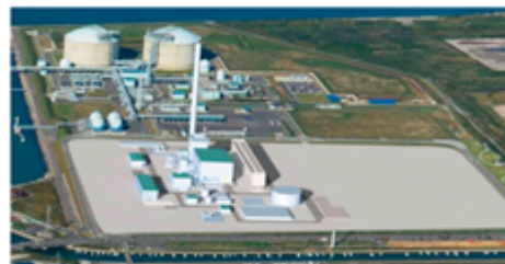
ひびき発電所 竣工イメージ
