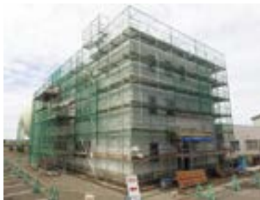
建設中の柏崎支社棟（平成29年10月13日時点）
