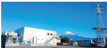
静岡ガス&パワー富士発電所
