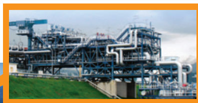
LNG貯槽から船側へ送る配管を設置しました
