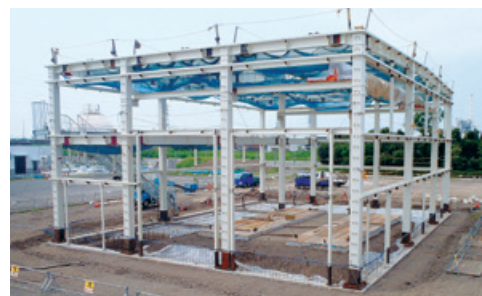
▲富士発電所建設風景 (2015年7月)
