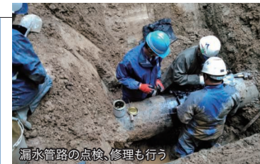
漏水管路の点検、修理も行う
