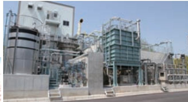
施設外観(大阪市平野下水処理場)
