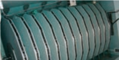
三次処理向け布ろ過装置（クロスメディアフィルター）
