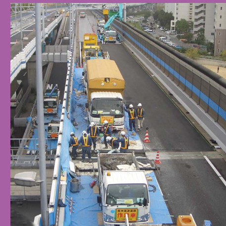
高速道路の補修工事
