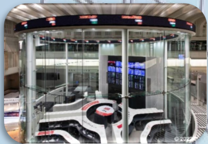
曲げガラス：東京証券取引所マーケットセンター
