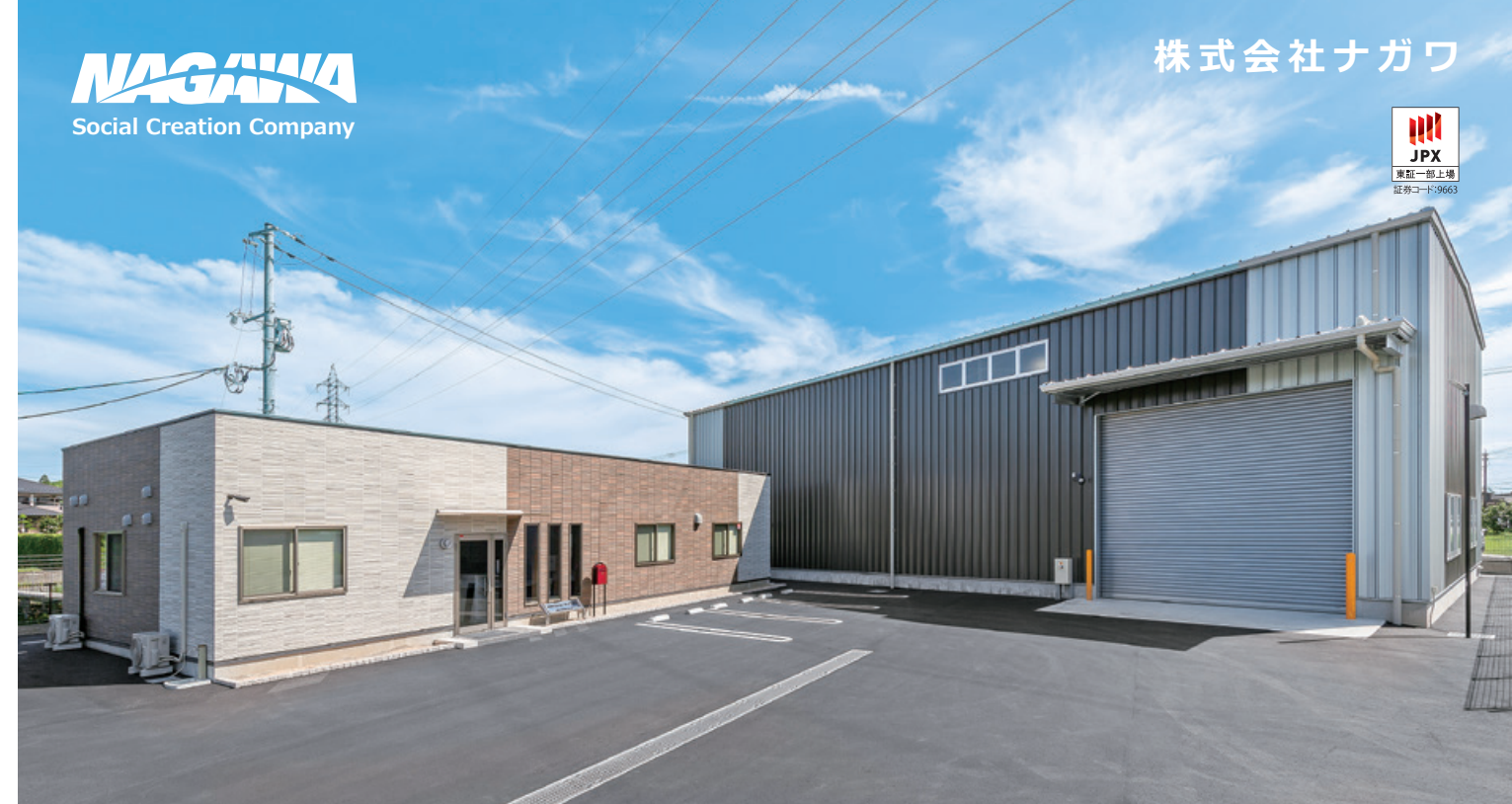
産業用機械工場・事務所
