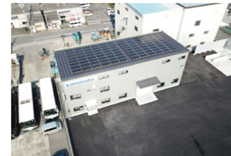
屋上に太陽光発電設備を設置した京都営業所 Solar Power Generation System Installed on the Roof of the Kyoto Branch Office
