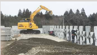
岩手県下閉伊郡田野畑村の道の駅建設工事
