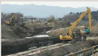
福島県南相馬市の河川災害復旧工事
