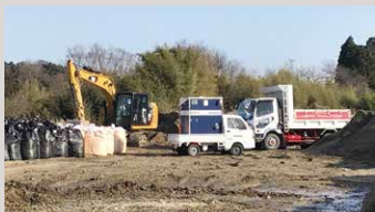
宮城県伊具郡丸森町の河川災害復旧工事
