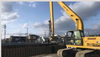
宮城県石巻市の橋梁新設工事
