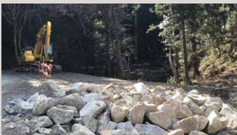
宮城県伊具郡丸森町の緊急治山工事
