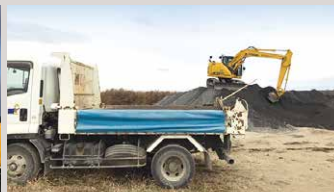
宮城県亶理郡亶理町の漁港海岸災害復旧工事
