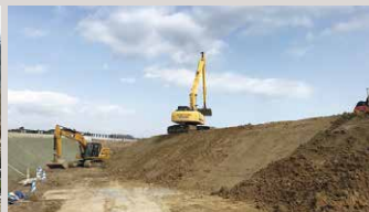
福島県双葉郡双葉町の河川災害復旧工事
