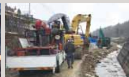
広島県山県郡北広島町の高潮堰周辺整備工事
