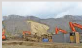
北海道勇払郡厚真町の法面復旧工事②
