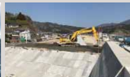
岩手県下閉伊郡山田町の水門工事
