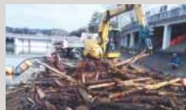
千葉県津市のダム湖流木処理工事
