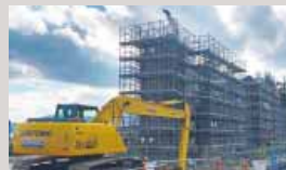
岩手県陸前高田市の防潮堤工事
