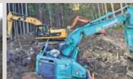
広島県山県郡安芸太田町の溪流外砂防堰堤工事
