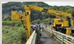
宮城県白石市の大熊橋補修工事
