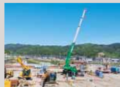
岩手県宮古市の水門復旧工事
