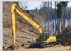
宮城県牡鹿郡女川町の飯子浜復興道路改良工事
