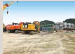
岩手県陸前高田市の水門復旧工事
