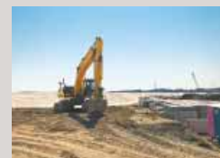
福島県南相馬市の防潮堤工事
