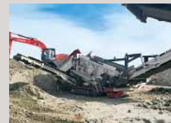
宮城県名取市の閉上港土質改良工事
