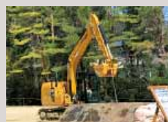
福島県双葉郡大熊町の汚染土壌仮置場造成工事
