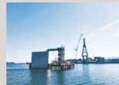
宮城県気仙沼市の気仙沼湾横断橋上部工事
