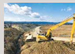
福島県双葉郡双葉町の防潮堤工事
