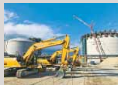
福島県相馬市のLNG基地建設工事
