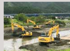
岩手県上閉伊郡大槌町の河川復旧工事
