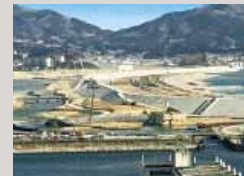
岩手県陸前高田市の防潮堤工事
