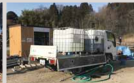
宮城県石巻市の大沢川河川改修工事
