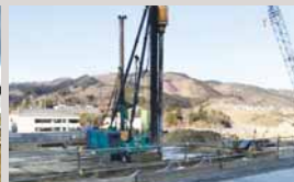
宮城県牡鹿郡女川町の学校建設工事
