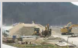
宮城県本吉郡南三陸町の河川改修工事
