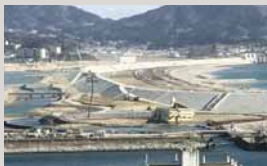
岩手県陸前高田市の防潮堤工事
