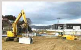
宮城県気仙沼市の五駄鮎線道路改良工事
