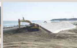
福島県南相馬市の防潮堤工事
