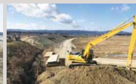
福島県双葉郡双葉町の防潮堤工事
