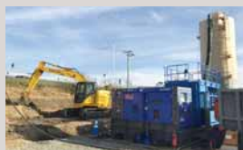
宮城県亘理郡山元町の山元道路改良工事
