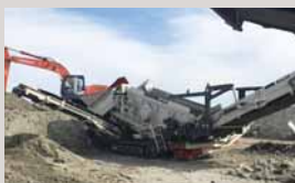
宮城県名取市の閉上港土質改良工事
