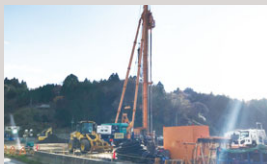
宮城県本吉郡南三陸町の防潮堤災害復旧地盤改良工事
