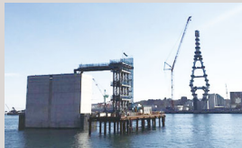
宮城県気仙沼市の気仙沼湾横断橋上部工事
