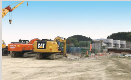
岩手県陸前高田市の水門復旧工事
