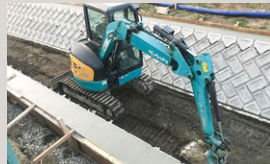
宮城県仙台市の宝塚用水路改修工事
