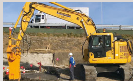
宮城県亶理郡山元町の山元地区道路改良工事
