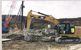
宮城県石巻市の複合文化施設建設工事
