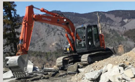
宮城県牡鹿郡女川町の飯子浜復興道路改良工事
