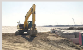
福島県南相馬市の防潮掘工事
