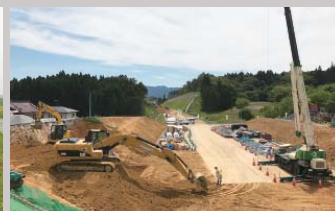
宮城県気仙沼市の赤牛川橋上部工事
