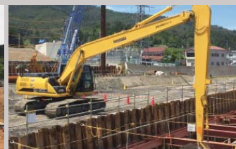
宮城県気仙沼市の鹿折川河川災害復旧工事
