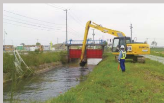
宮城県亶理郡山元町の花笠排水路復旧工事
