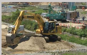
岩手県陸前高田市の高台造成工事
