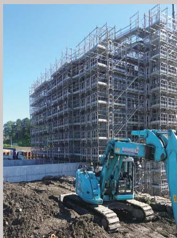
岩手県陸前高田市の水門工事
