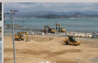
宮城県本吉郡南三陸町の防潮堤工事
