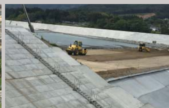
岩手県陸前高田市の防潮堤工事
