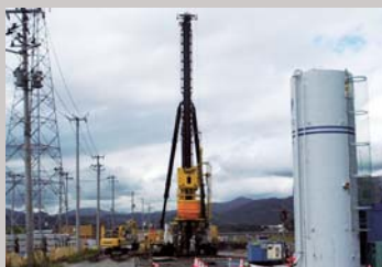
岩手県大船渡市の盛川道路改良工事
