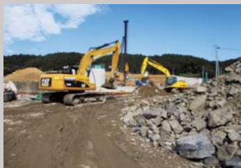
宮城県気仙沼市の復興道路整備工事
