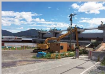
岩手県陸前高田市の気仙川の水門新設工事
