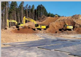
宮城県石巻市の防災集団移転工事
