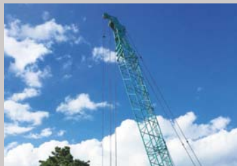
宮城県岩沼市の五間堀川河川災害復旧工事
