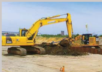
宮城県岩沼市の岩沼海浜緑地工事
