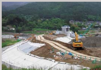
岩手県大船渡市の防潮堤工事
