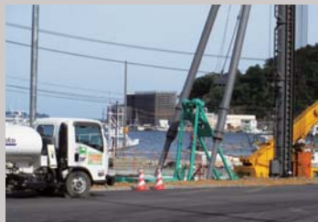
宮城県牡鹿郡女川町の国道398号新設工事
