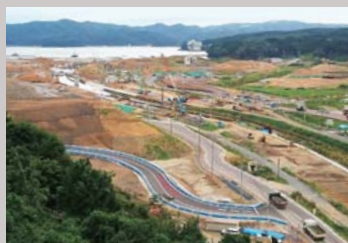
宮城県本吉郡南三陸町の復興工事
