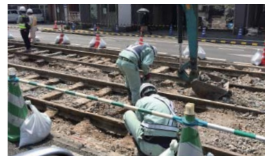
早急に再開を果たした熊本市電。写真は復旧作業の様子
