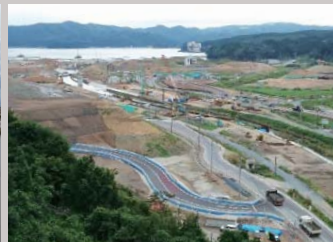
宮城県本吉郡南三陸町の復興工事
