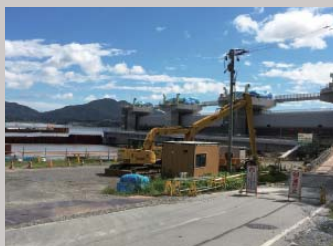
岩手県陸前高田市の気仙川の水門新設工事
