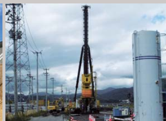
岩手県大船渡市の盛川道路改良工事
