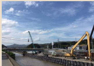
宮城県気仙沼市の河川外災害復旧工事
