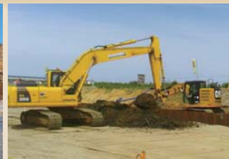
宮城県岩沼市の岩沼海浜緑地工事
