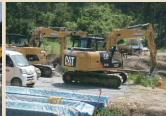
宮城県本吉郡南三陸町の河川改修工事
