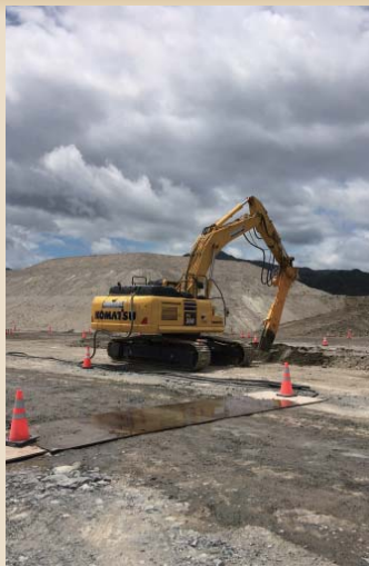
岩手県釜石市の防潮堤工事
