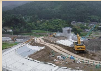
岩手県大船渡市の防潮堤工事
