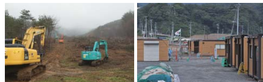
宮城県気仙沼市の防災集団移転工事
