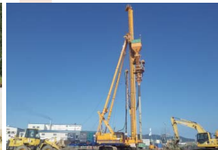
宮城県石巻市の地盤改良工事
