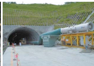
岩手県盛岡市の手代森トンネル工事
