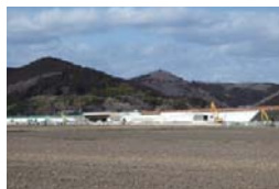
宮城県石巻市の三陸道拡張工事
