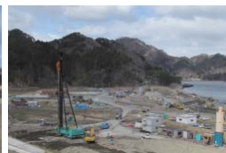
岩手県釜石市の高台移転工事
