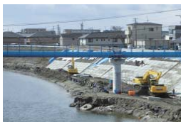
宮城県仙台市の護岸工事
