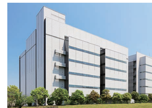
netXDC 千葉第3センター (S13)
