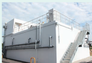
▲排水処理施設
