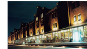
横浜赤レンガ倉庫2号館(2002年)
