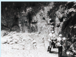
1958 中央自動車道地表踏査
