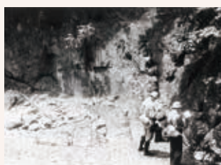
1958 中央自動車道地表踏査
