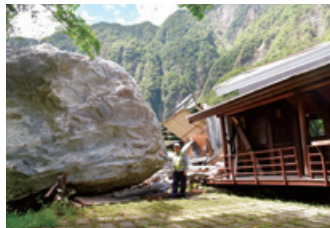
太魯閣国立公園の落石状況と建物(ホテル)の被災状況
