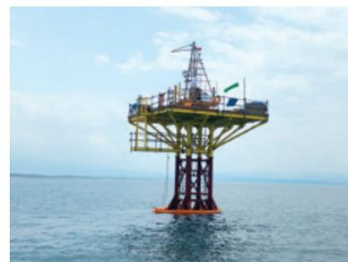
海底地盤調査鋼製檣の上からボーリング調査を行っている様子
