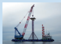
運搬中の海底地質調査用足場(鋼製櫓)
