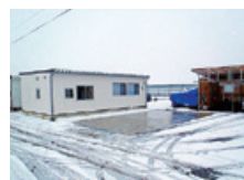
地下水熱交換システムによる駐車場の路面融雪
