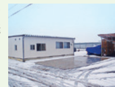
地下水熱交換器による路面融雪 (山形県鶴岡市での実証実験状況)
