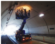
▲トンネルの健全度調査の様子
