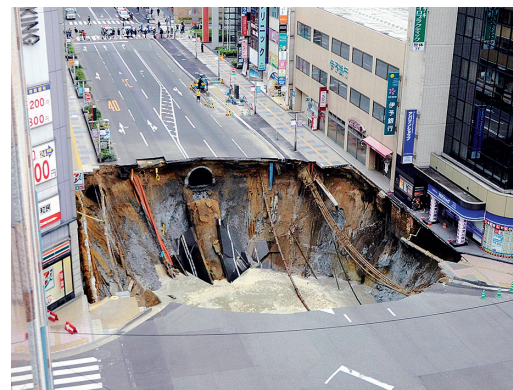
▲ニュースにも取り上げられた福岡市の大規模陥没
