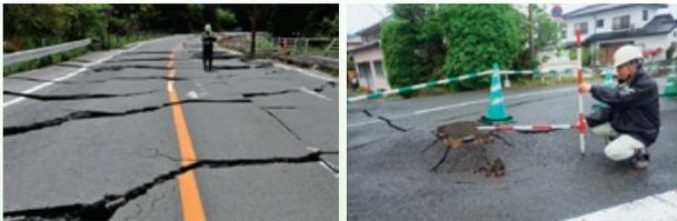
道路などインフラ構造物の損傷状況を調査。復旧に向けて、法面や盛土の崩壊原因を調査し、対策工の検討などを行っています。
