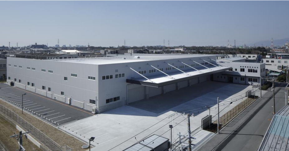
▲ 大阪物流センター（大阪府豊中市）
