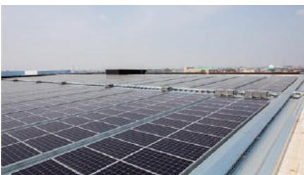
屋上には一面に2,832枚のソーラーパネルを設置しており、年間約54万kWhの発電量を見込んでいます。
