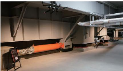
災害時でも供給責任を果たせるように地下には免震装置を設置。
