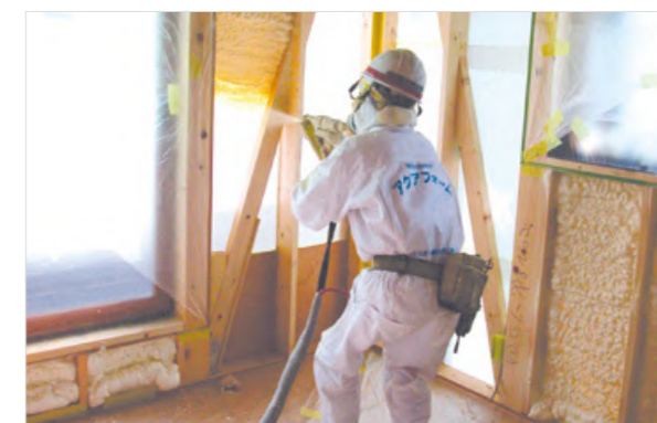
アクアフォーム吹付工事
