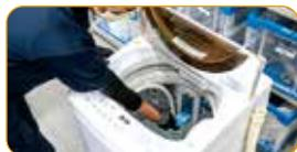
給水ホース、糸くずフィルター、排水ホースを取り付けます。
