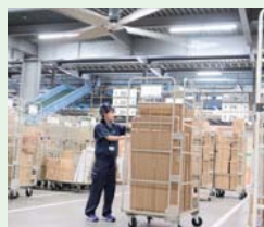
大型天井扇を設置した物流センター
