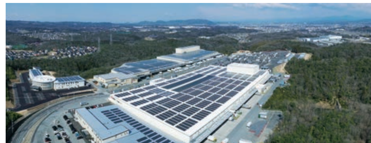
屋根に太陽光パネルを設置している人材開発センター。グループ全体で再生可能エネルギーへの取り組みを進める
